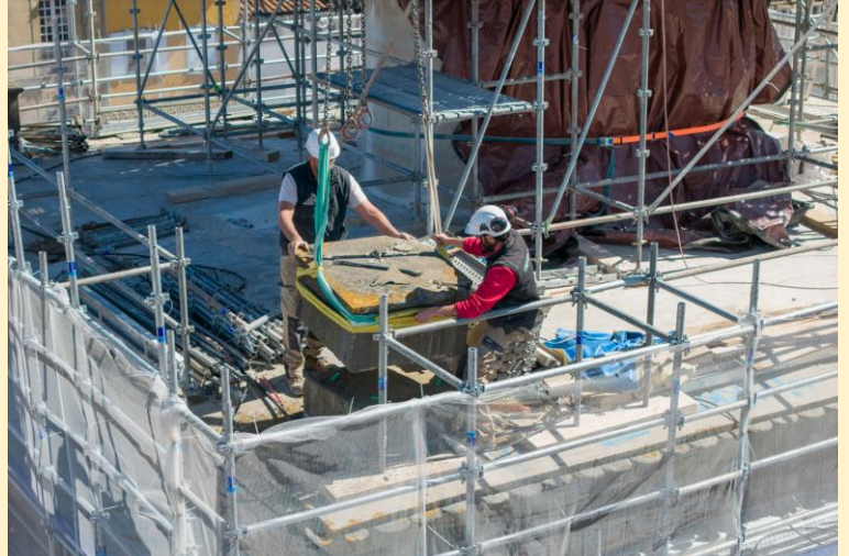
Dépose des pierres d'angle
