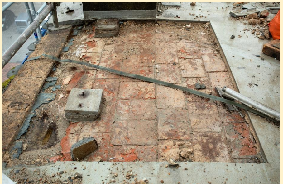
Sondage réalisé pour voir la composition du sol
