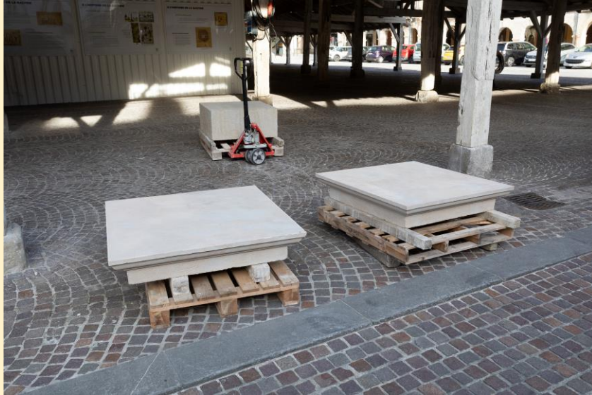
Les éléments des pierres d'angle de retour sous la halle
